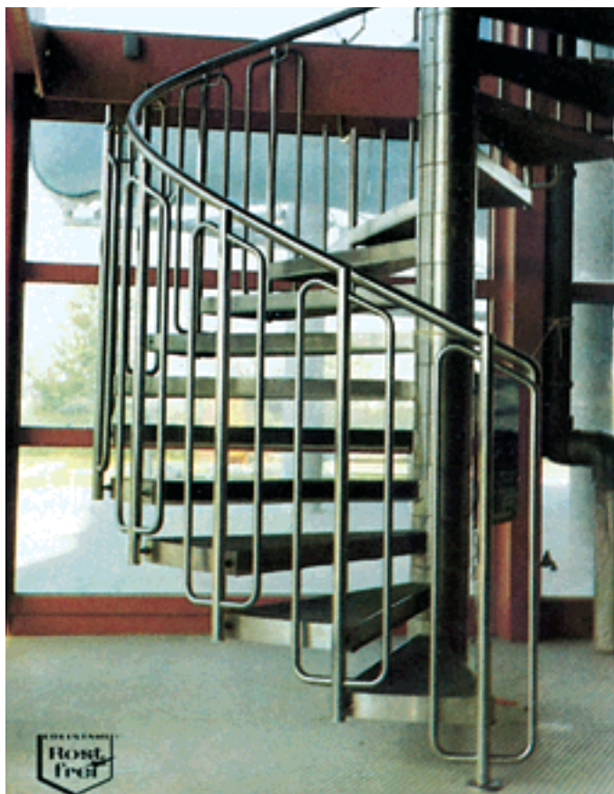
Wendeltreppe komplett aus V4A-Edelstahl, 2,4 m Ø, fein geschliffen und poliert
