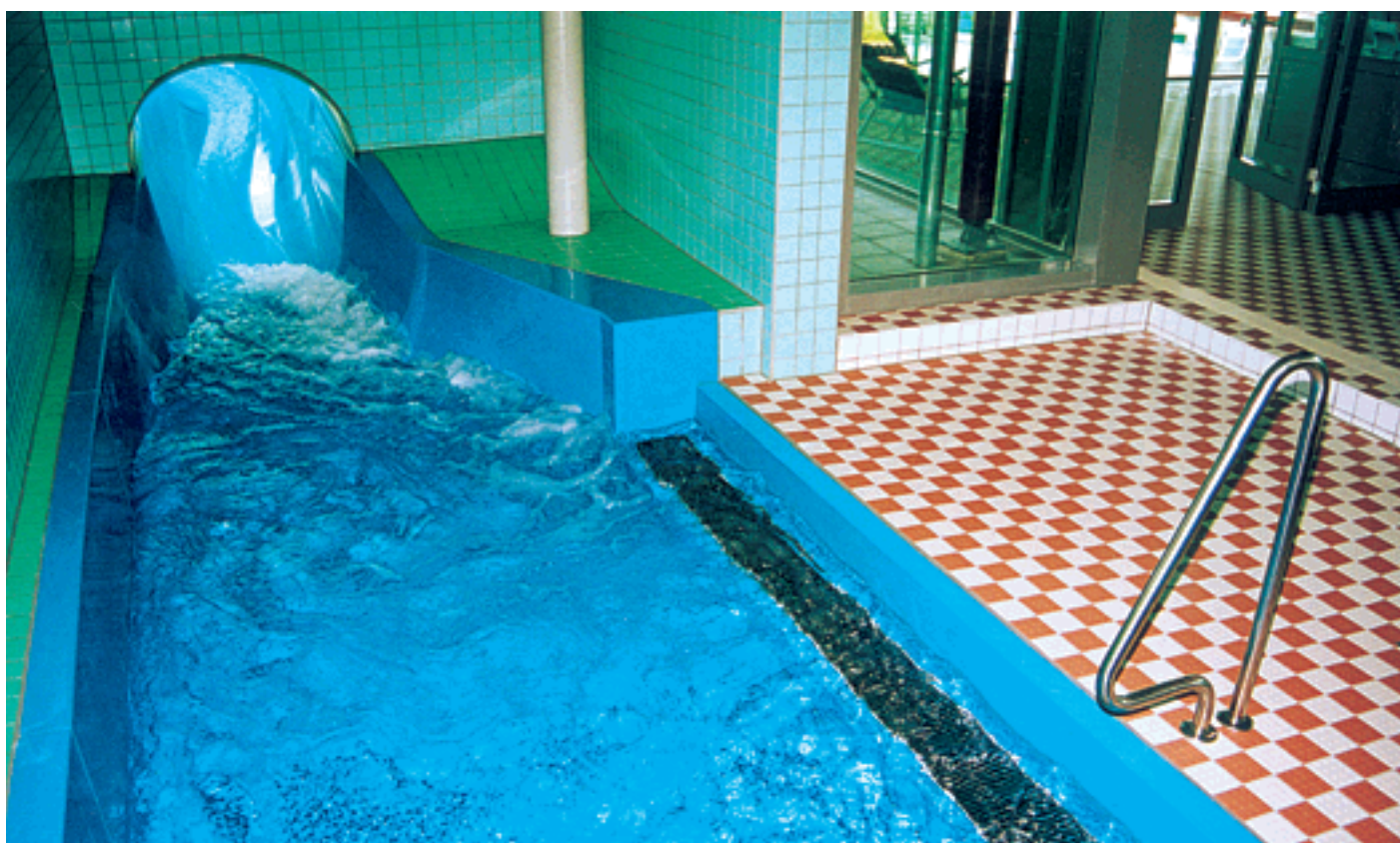
Flachauslauf in breiter Bauweise Typ RSE 2000 - Abmessungen ca. 6,0 m lang, ca. 2,5 m breit
