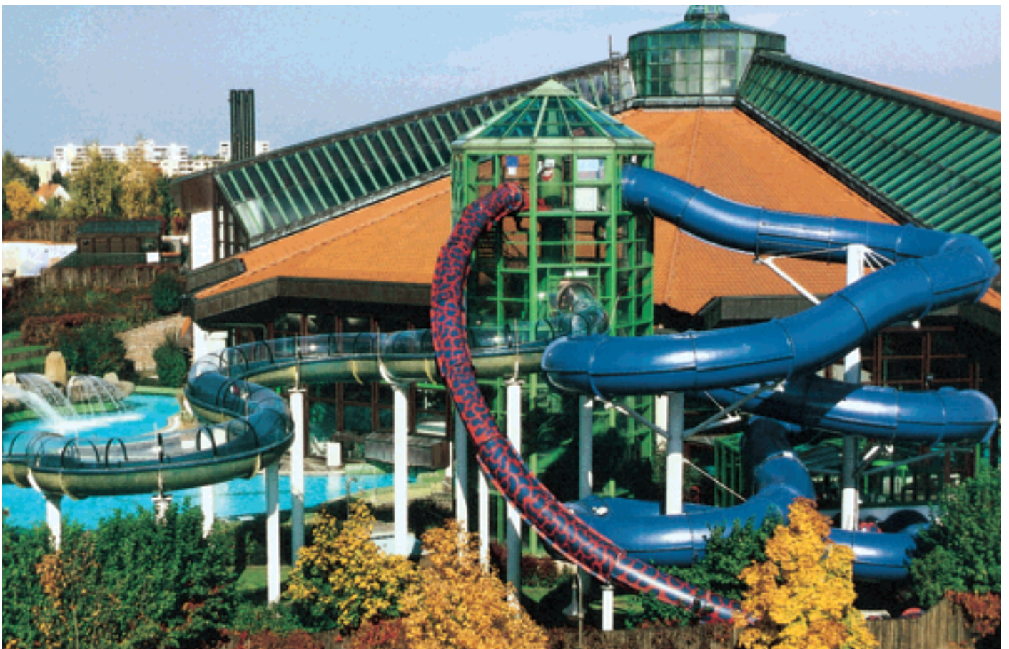
Königstherme Königsbrunn , ca. 100 m Black Hole, ca. 41 m Turborutschbahn in transluzentem Schlangenmuster rot-gelb, mit separatem 8-eckigem Turm mit Doppelaufstiegstrepfen, Wendel- und Spindeltreppe und separaten Landehaus für beide Rutschen.
