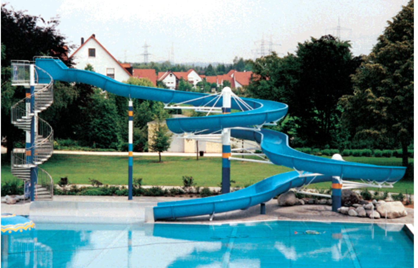
Freibad Meitingen , Typ R 97/1400 mit Edelstahlsicherheitsauslauf, Start: ca. 7,2 m, Länge: ca. 69 m
