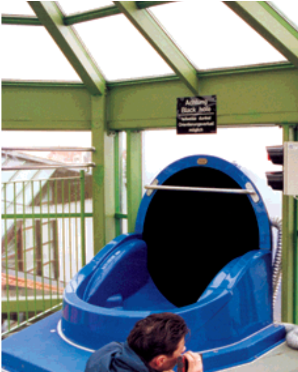
Startbecken für Black Hole 1,4 m Ø, 180 m 3 /h Wasserbedarf
