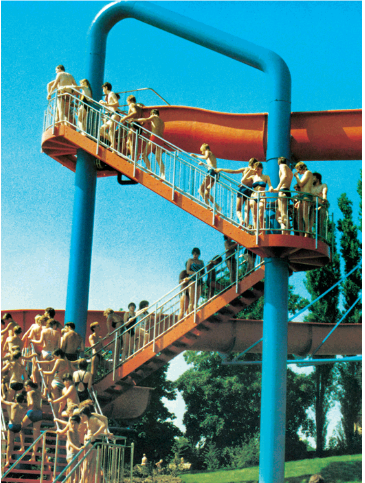
Geradlinig verlaufender Treppenaufgang , Ruhepodeste und Stufen mit rutschfesten GfK-Belägen, Carborundumbeschichtung, Geländer aus Edelstahl. Treppenbreite 0,80 m.
