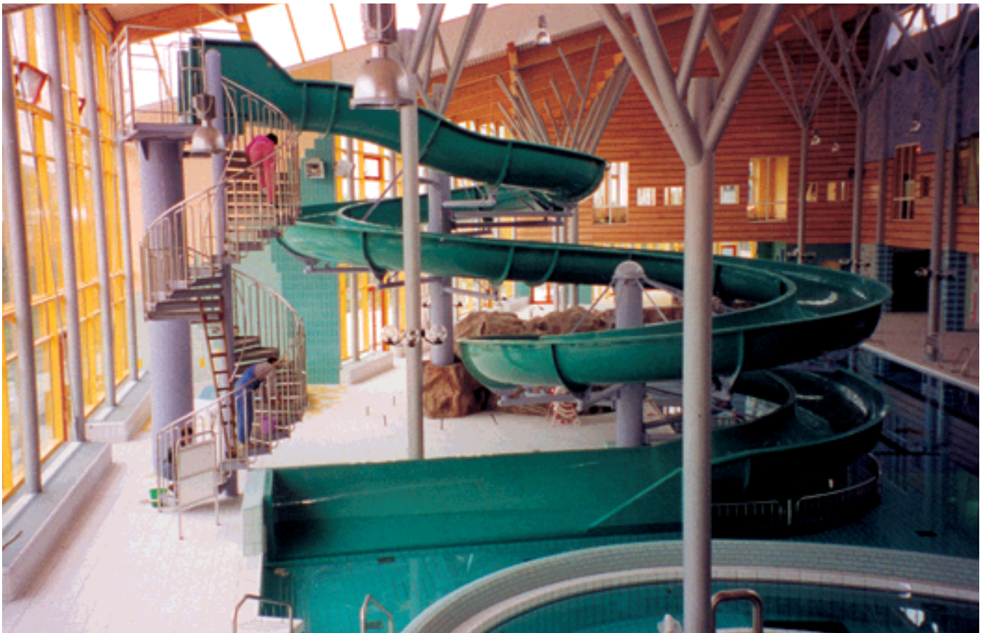
Freizeitbad Seiffen , Typ R 97/1400 mit Sicherheitsauslauf, Starthöhe: ca. 6,7 m, Länge: ca. 64 m
