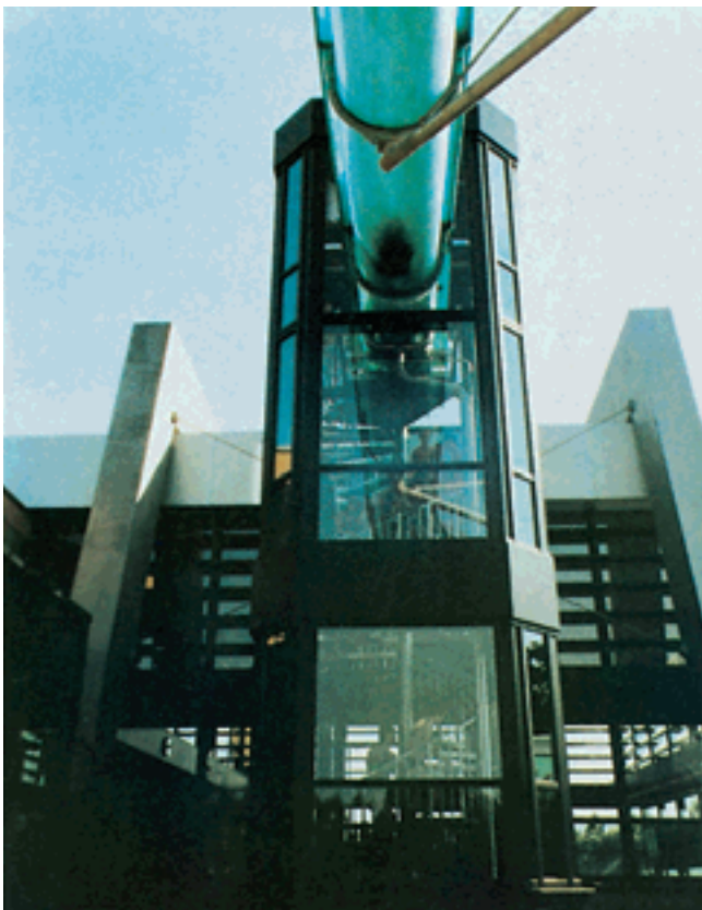
Startturm , achteckig, Wendeltreppe komplett aus Edelstahl, Stufen und Podestbeläge aus wartungsfreiem GfK mit rutschfester Carborundumbeschichtung.
