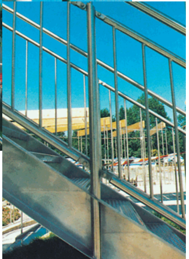
Treppenanlage , geradlinig, komplett aus V4A-Edelstahl, mit Edelstahlstufen, rutschfest, düsenlochprofiliert.
