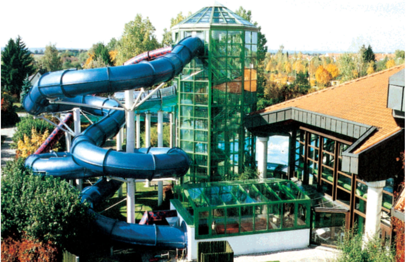
Königstherme Königsbrunn , ca. 100 m Black Hole, ca. 41 m Turborutschbahn in transluzentem Schlangenmuster rot-gelb, mit separatem 8-eckigem Turm mit Doppelaufstiegstrepfen, Wendel- und Spindeltreppe und separaten Landehaus für beide Rutschen.
