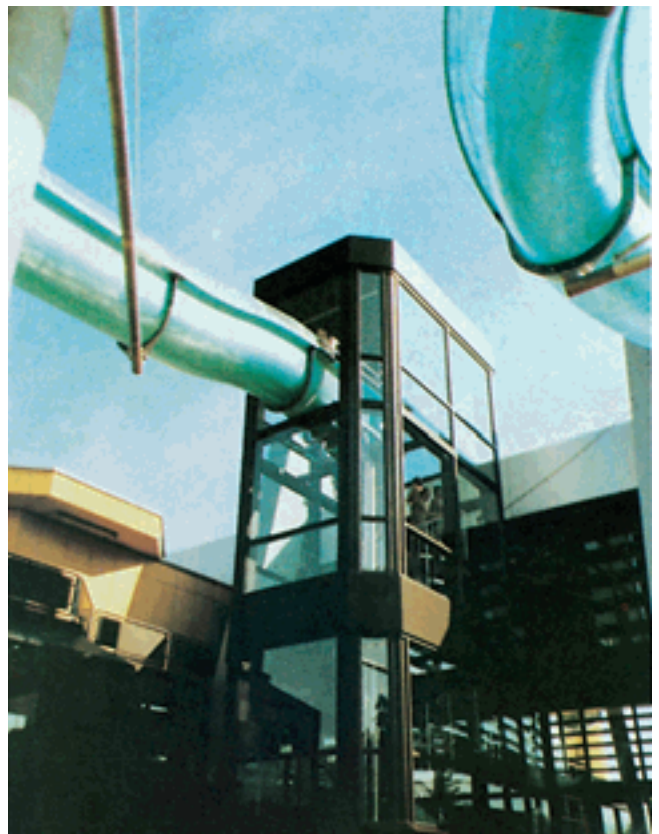
Fassade aus Aluminiumprofilrahmen, braun eloxiert, mit Sicherheitsdoppelverglasung.
