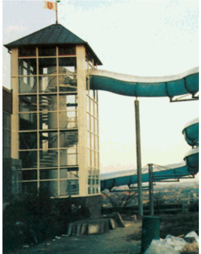
Startturm , quadratisch, Betonwendeltreppe mit Edelstahlgeländer, feuerverzinkte Stahlkonstruktion, mit eloxierter Aluminiumfassade, Sicherheitsdoppelverglasung.
