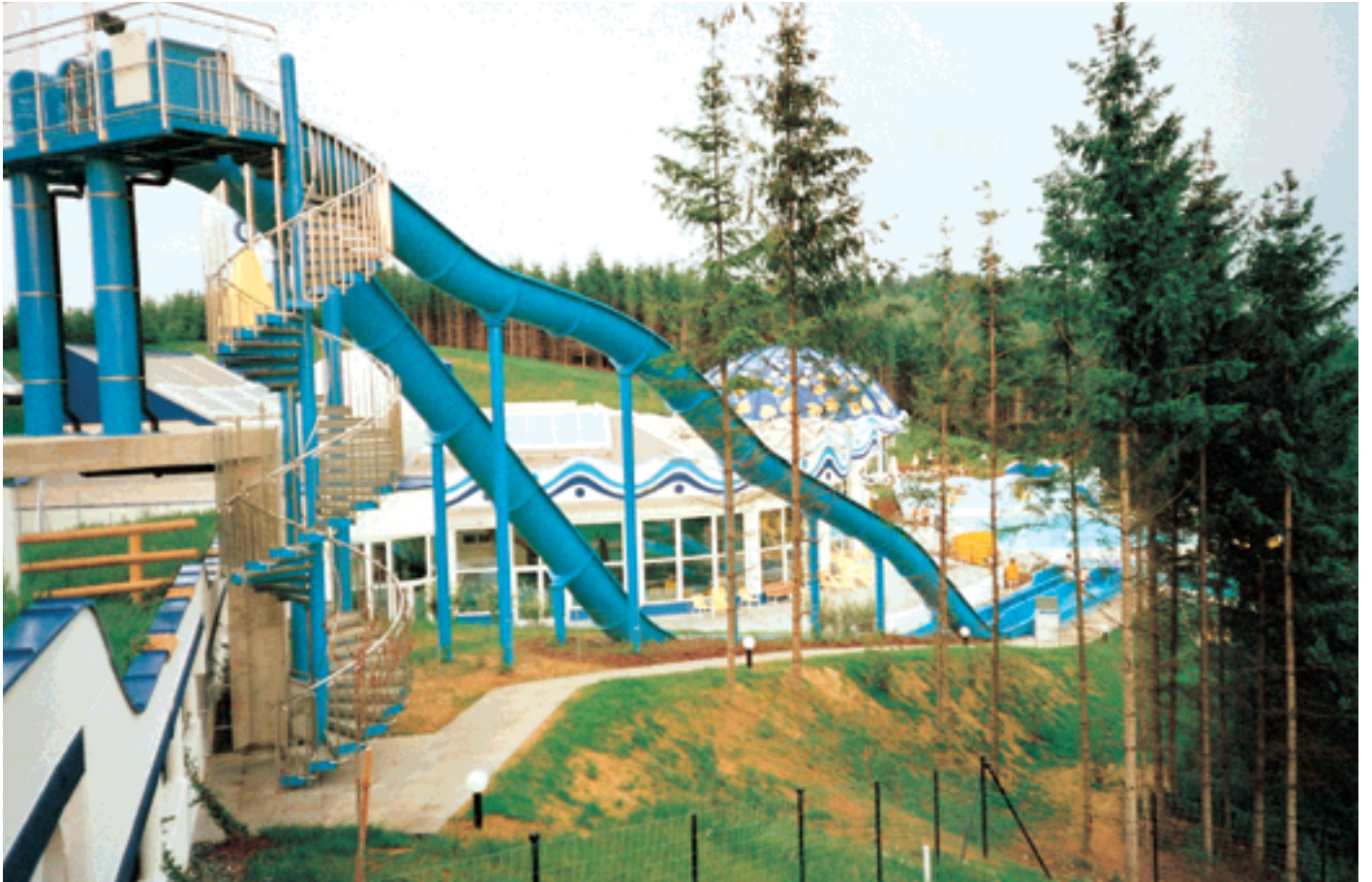
Wendeltreppe und Startpodest mit Edelstahlgeländer, Höhe ca. 14 m.
