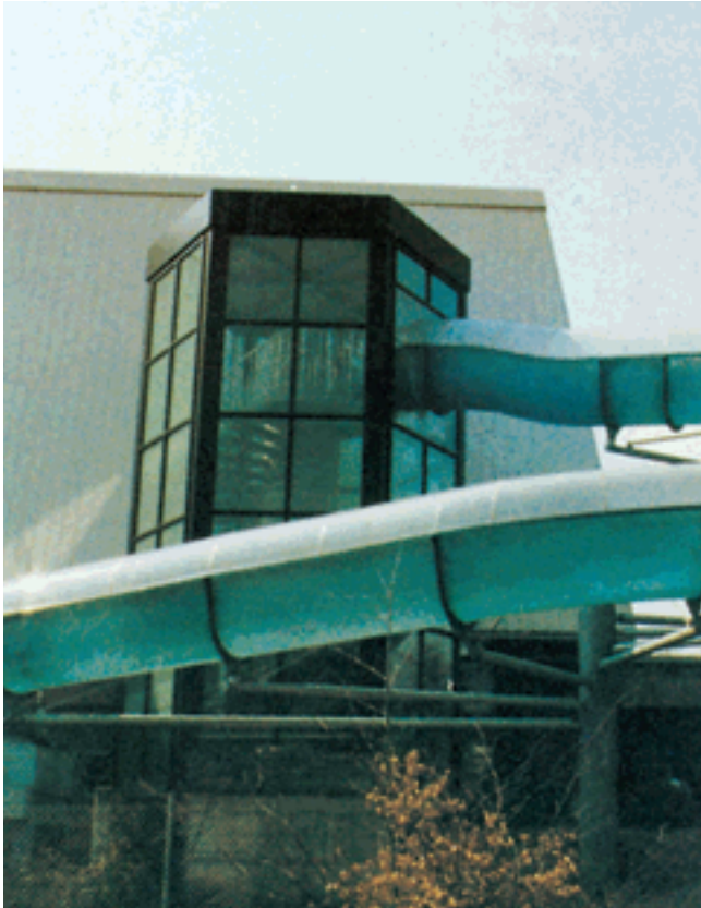
Startturm , sechseckig, symmetrisch, Betonwendeltreppe mit Edelstahlgeländer, feuerverzinkte Stahlkonstruktion, mit eloxierter Aluminiumfassade, Sicherheitsdoppelverglasung.
