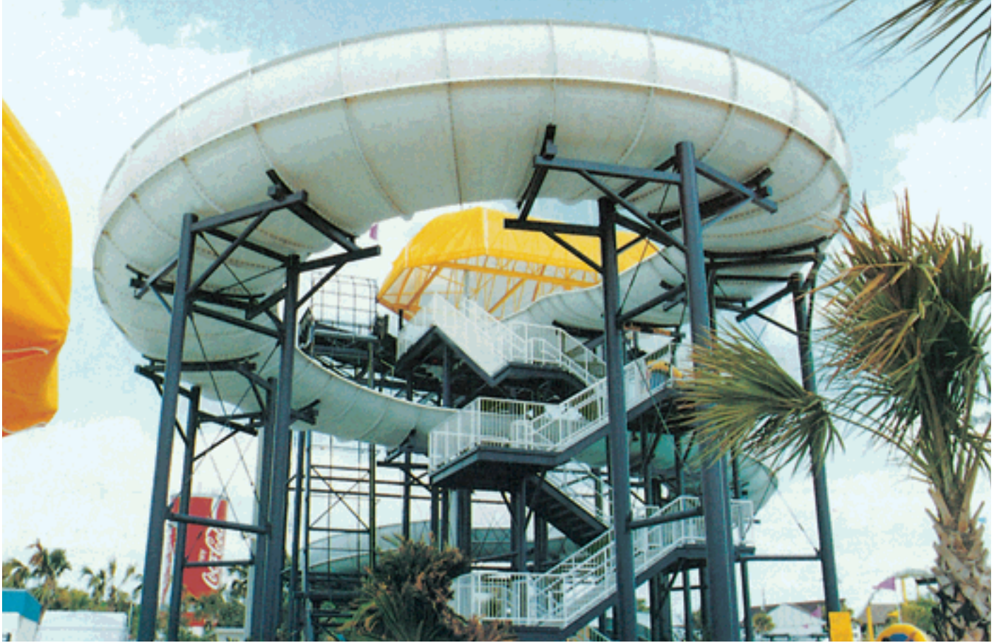
Abbildung Typ R 91/4000 aufgeständert, geradläufige Aufstiegstreppe · Länge der gezeigten Bahn ca. 100 m.
