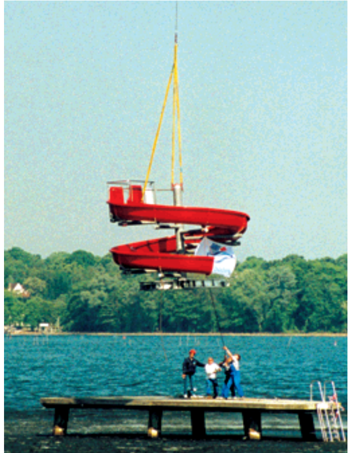
▲ Rutschbahnmontage mit Hubschrauber im Wannensee Berlin – Nichts ist unmöglich . . .
