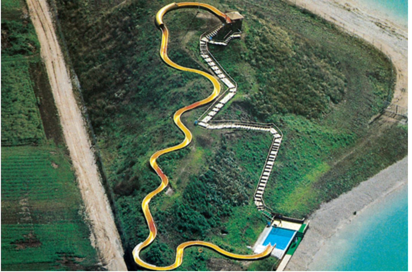
Abbildung: Freizeitanlage Mammendorf , Typ: R 84/900, erdverlegt, Farbe: gelb RAL 1007 in drei verschiedenen Abstufungen, Länge: 173 m (längste erdverlegte Rutschbahnanlage Europas!) mit 8 Jumps, Starthöhe: 16,5 m. Aufgang: dem Berg angepaßter Holztreppenaufgang.
